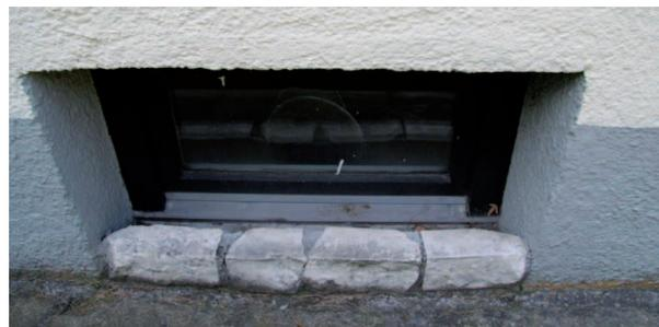
Bild 5: Einfache Schutzmaßnahme am Kellerfenster
